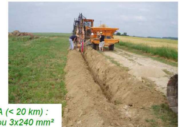
Enfouissement câbles : 0,5 à 1 m de profondeur
