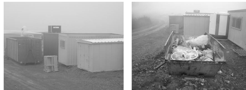
Illustration 12 : Exemples de base de vie sans raccordement possible aux réseaux
